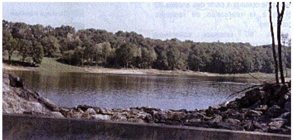
Réservoir de Fargues - Mise en eau janvier 1997
